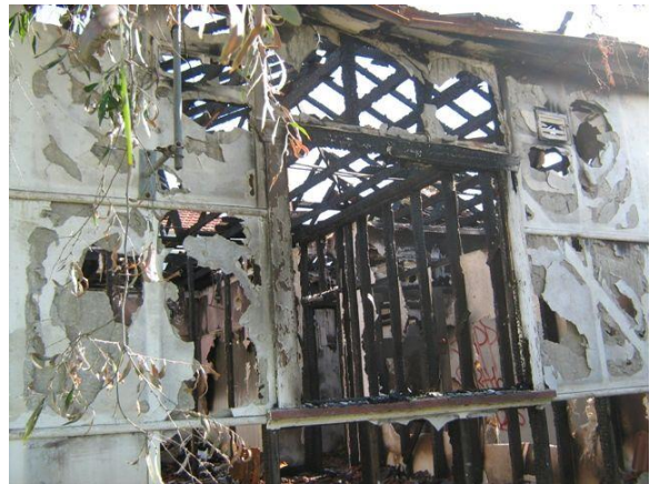
Asbesto en un edificio dañado por el fuego
