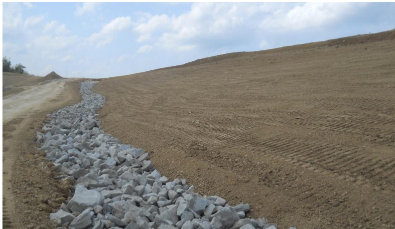
Figura 4: Canal de aguas pluviales a lo largo del perímetro del relleno
