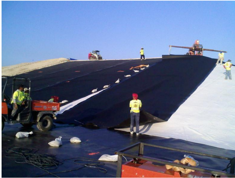
Figura 14: Desplazamiento de la geomembrana
