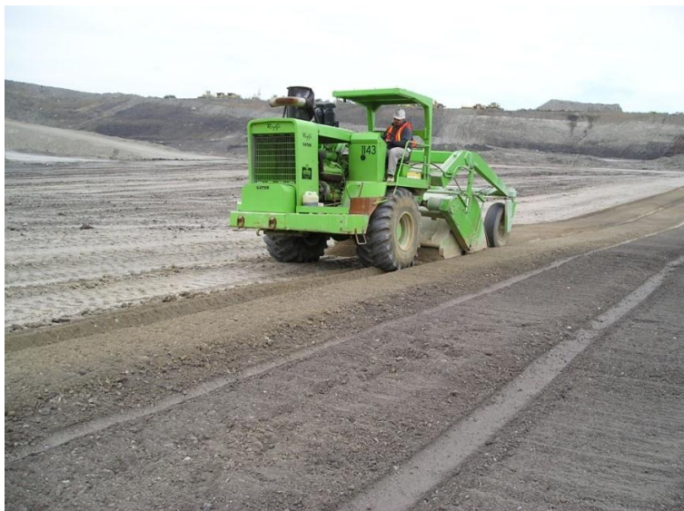
Figura 8: Procesamiento del suelo del recubrimiento para controlar el tamaño de terrones
