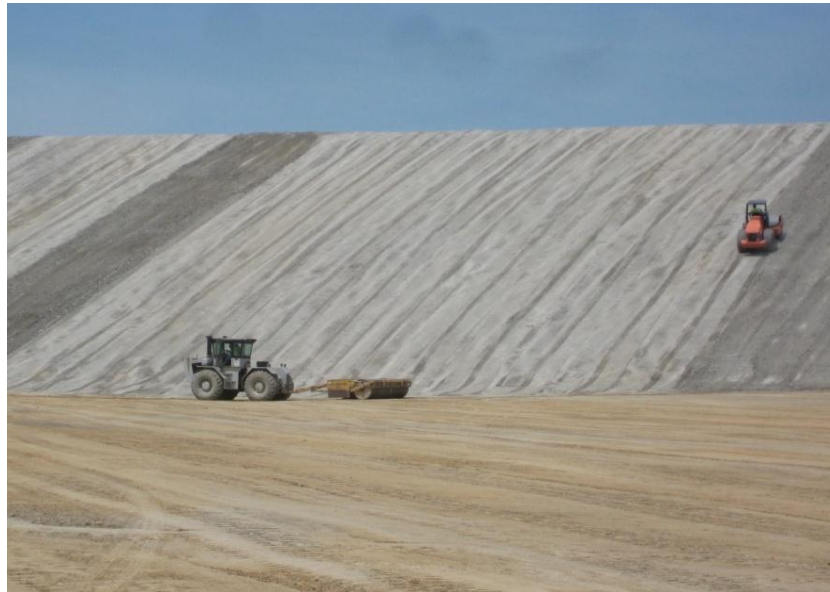
Figura 5: Cargas paralelas en una proporción de 3:1 en una pendiente lateral
