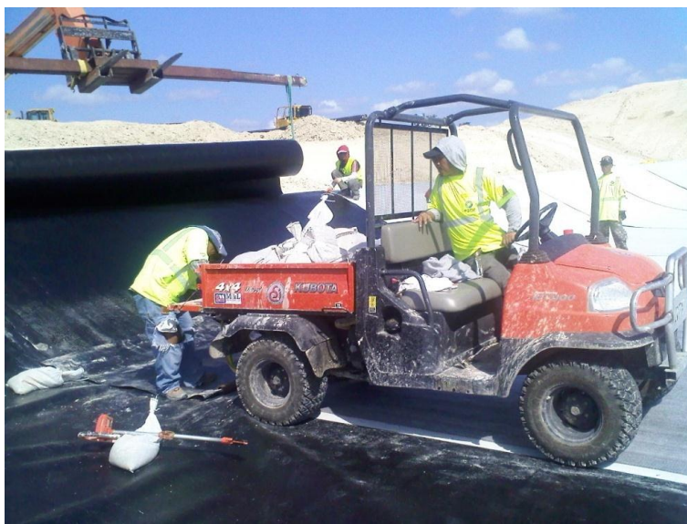
Figura 15: Vehículos de baja presión sobre el suelo, todo terrenos, sobre la geomembrana
