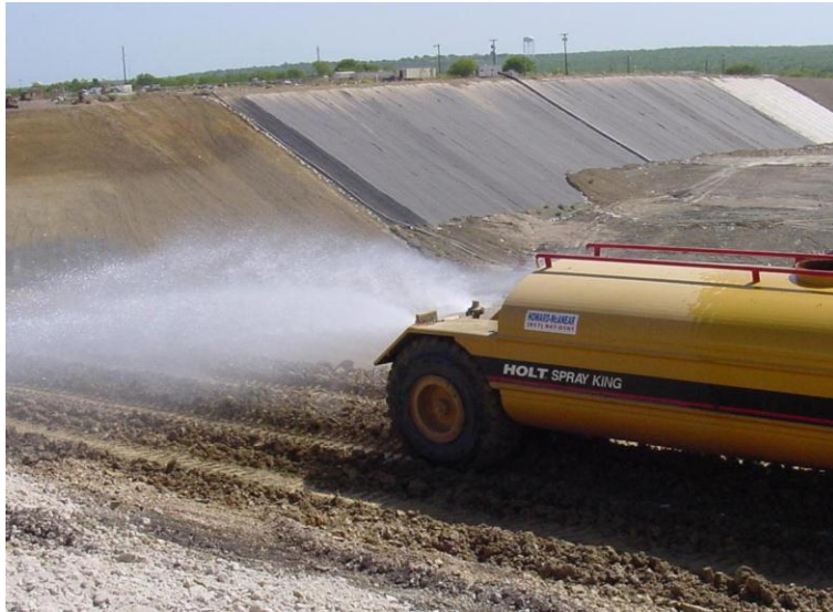
Figura 7: Hidratación del recubrimiento del suelo
