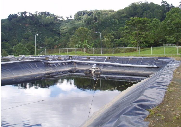
Figura 32: Laguna revestida con aireación para el tratamiento de lixiviados
