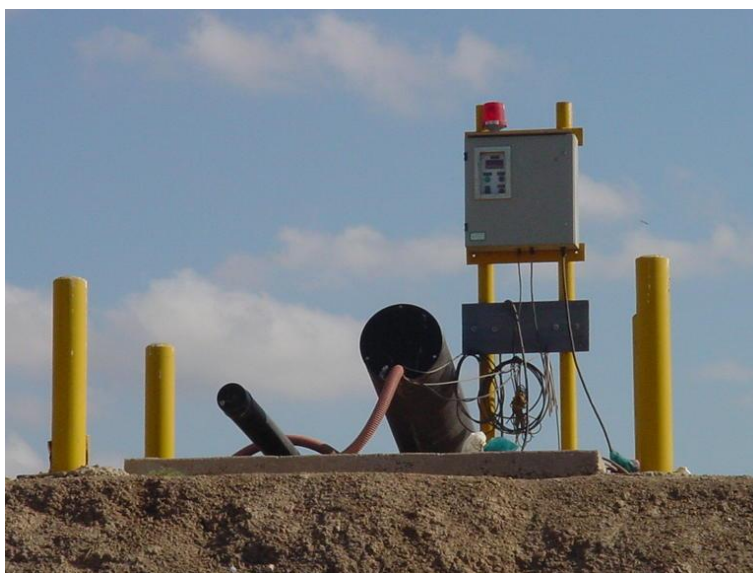
Figura 31: Tubería de elevación para lixiviados y sistema de distribución
