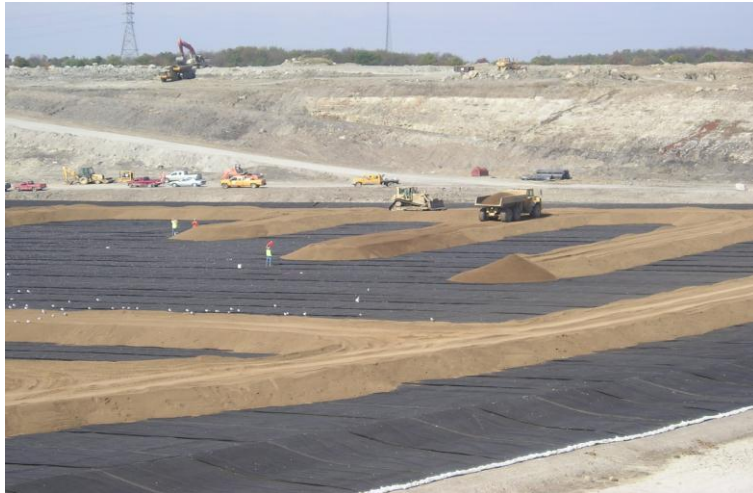
Figura 24: Cubierta protectora desplegada en tramos
