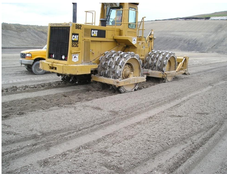
Figura 9: Compactación del recubrimiento del suelo
