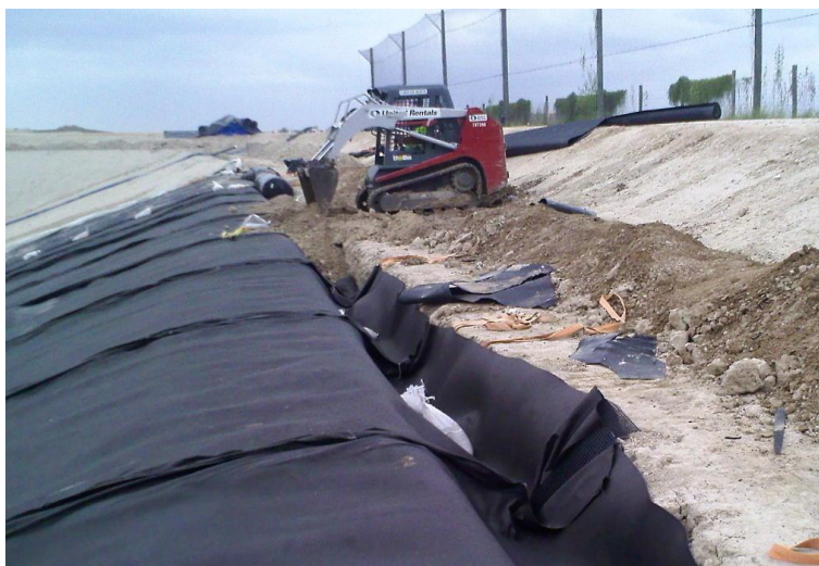
Figura 23: Zanja de anclaje rellena con suelo
