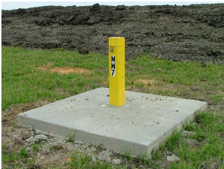
Figura 40: Finalización del pozo de monitoreo de aguas subterráneas con recubrimiento, seguro y plancha de concreto
