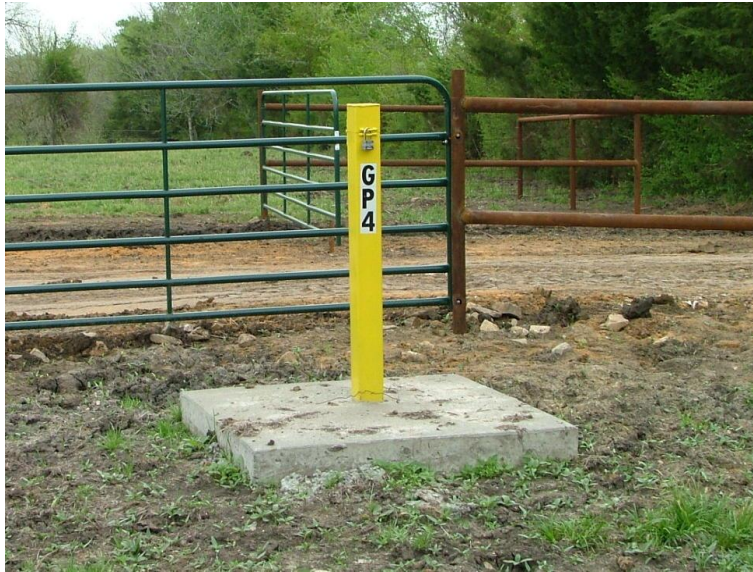
Figura 41: Sonda de gas en un relleno
