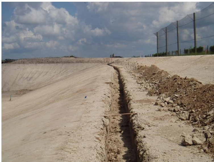
Figura 22: Zanja de anclaje durante excavación
