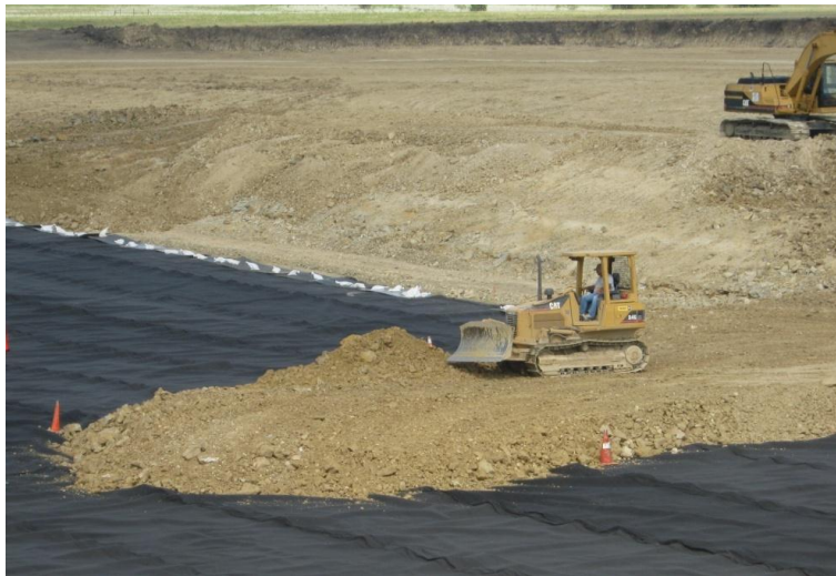
Figura 10: Colocación de la cubierta protectora
