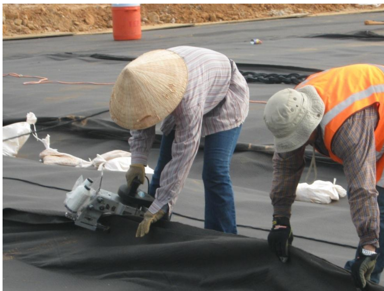
Figura 27: Coser geotextil
