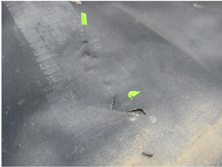
Figura 21: Daño a recubrimiento de HDPE con indicador de reparación
