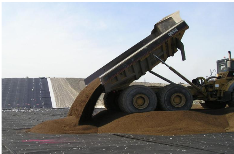
Figura 25: Colocación de capa de drenaje granular al final de un tramo
