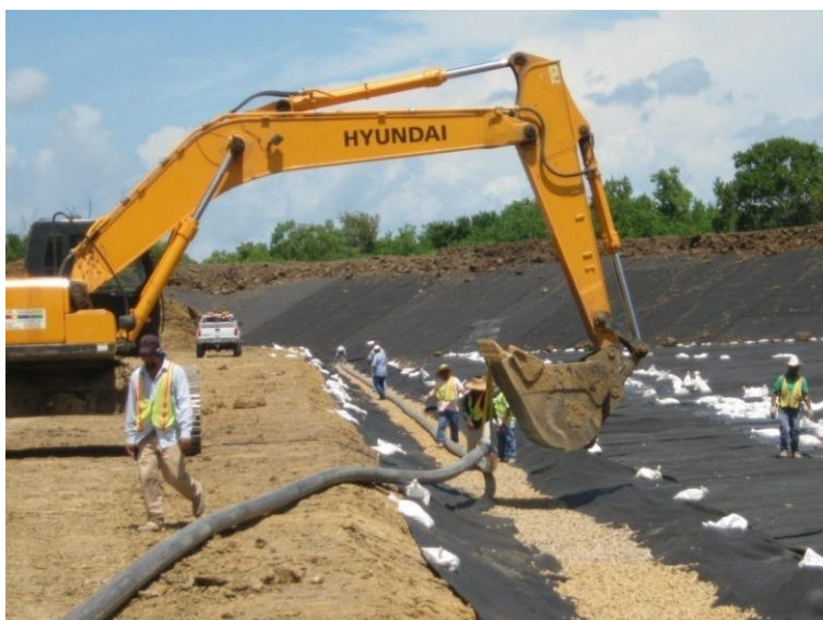
Figura 29: Instalación de tubería de recolección de lixiviados
