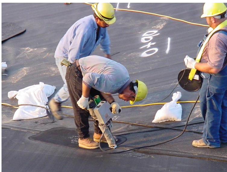
Figura 17: Geomembrana de soldadura de extrusión
