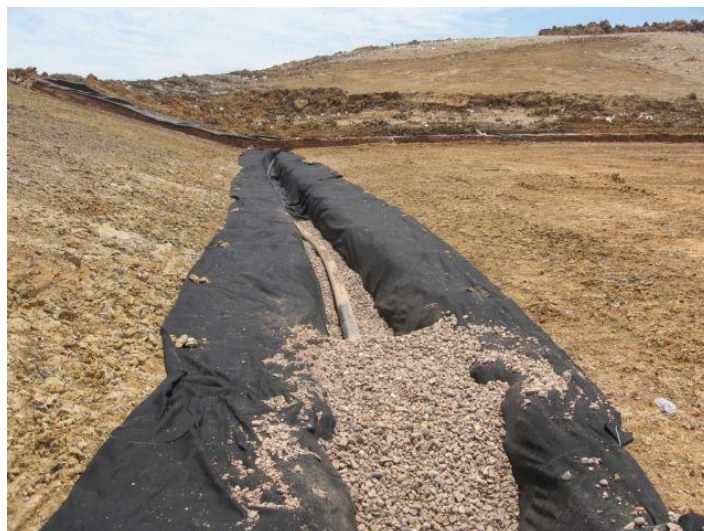
Figura 34: Drenaje subterráneo para retirar aguas subterráneas
