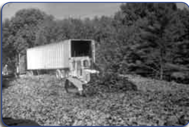
Figura E-2. Oruga Caterpillar D-4 esparciendo el ADL como relleno ligero del terraplén en el Intercambio Vial del Aeropuerto de Portland
